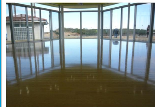
フロアーに全面ガラス張りの快適空間。
